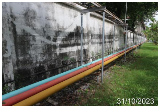
รูปที่ 3-15 ท่อส่งน้ำประปาภายในโรงงาน (สีฟ้า)
