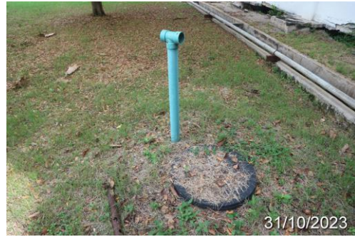
รูปที่ 3-2 ถังบำบัดน้ำเสียสำเร็จรูปในส่วนของสำนักงาน
