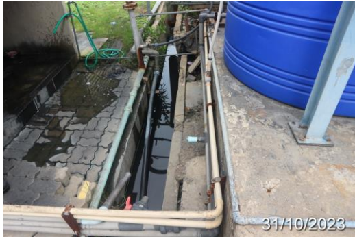
รูปที่ 3-7 รางระบายน้ำที่ติดตั้งจากท่อหล่อเย็น
