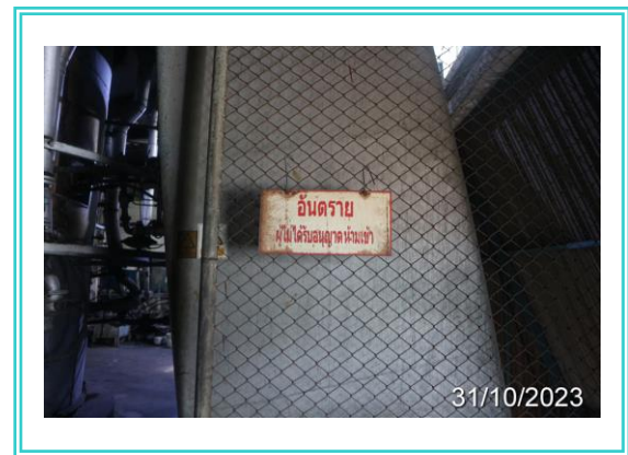
รูปที่ 3-30 ป้ายเตือนบริเวณสัมผัสความร้อน พร้อมโซ่เหล็กกันและฉากกันความร้อน
